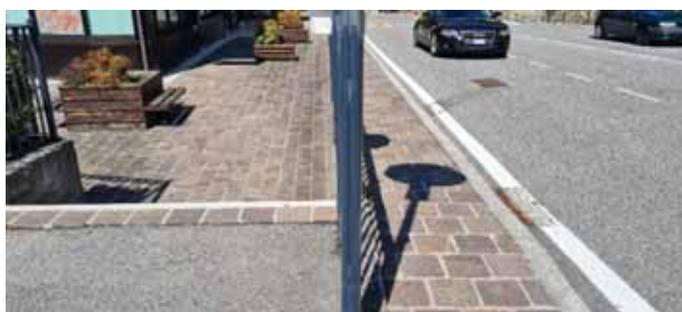
Verso l'edificio del Comune è stato realizzato un percorso protetto: deve essere ampliata la sezione del percorso.
